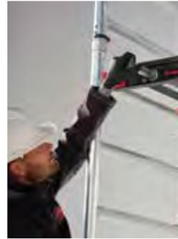
„Zusätzliche Haken“ zum Aufhängen der Gerüstbauteile beim Auf- und Abbau des MiTOWER Fahrgerüst. In nur einer schnellen Bewegung ein- und auszuschieben.
