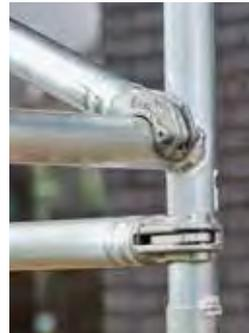
Gepresste Verbindung zwischen Klaue und Strebenrohr.
