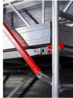
Bordbretter aus Aluminium lassen sich leicht montieren.
