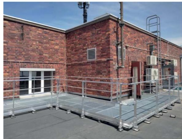
Durchdringungsfreie selbsttragende Konstruktion
