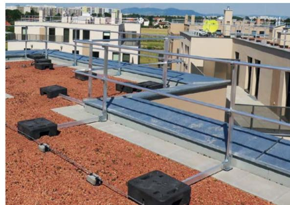
Sicherheitsgeländer selbsttragend Standard als Dachrandsicherung
